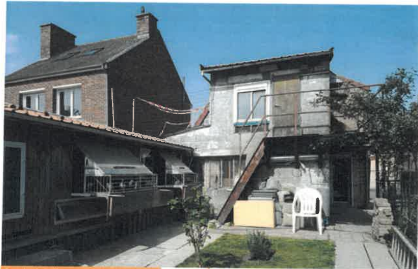
Les installations vues de l'extérieur
